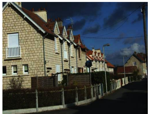
Maisons des contremaîtres
